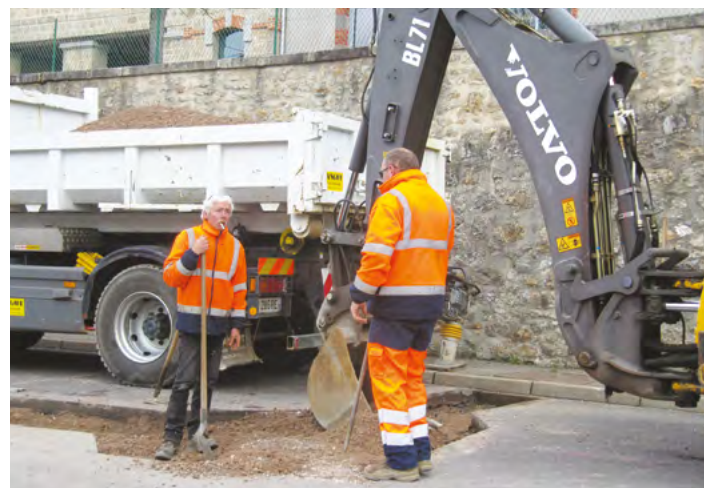
Travaux sur le réseau d'eaux pluviales
