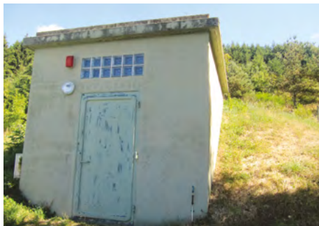
Réservoir de Palladuc (300m³)
